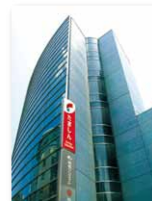
ブルームセンター全景
