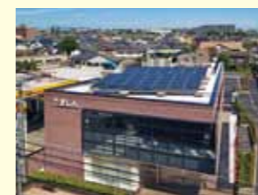
〈太陽光パネルの設置事例〉
