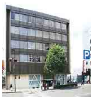
宮城第一信用金庫 本店外観
