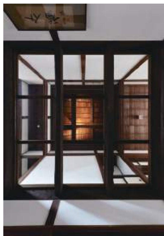
1 階から 2 階の天井の梁を見ることができる。
