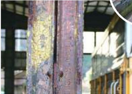
扇形機関庫の柱に使われている 1885 年製イギリスのチャールズ・キャンメル社製のレール
