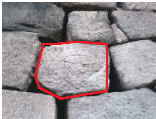
隠し曲輪(くるわ)にある石垣。刻印は、大洲藩・加藤家のもの
