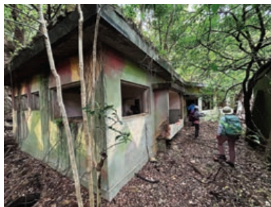
（写真上）急峻な半島の突先にある聴音室跡天井。正面奥は九州（写真中右）聴音室跡の内部（写真中左）L字形の防空壕は通り抜けができる（写真下）兵舎跡の壁にはカモフラージュの塗装が今もハッキリと分かる *俳人の夏井いつきさんは愛南町内海家串の出身
