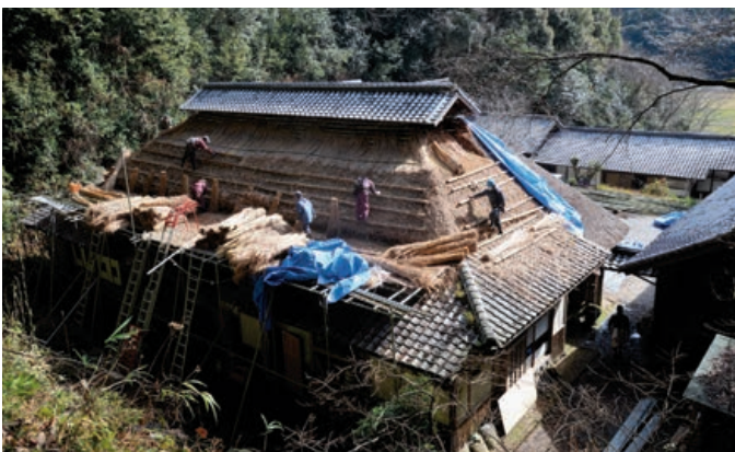
1998年に全面ふき替えを行い、その後2019年に前面、2021年に後面をふき替えた。（撮影：宮本春樹）
