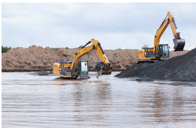
▲高品質を誇る天塩の砂や砂利の掘削現場は、危険だからこそ安全が第一。社長自身、ダンプの運転、オペレーターもこなす。大型・大型特殊、車両系建設機械運転者、運行管理者(貨物)の資格を持ち、砂利採取業務主任者として第一線に立つ。
