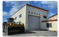
工場兼車庫/新栄通4丁目 大型車両や洗浄プラントの整備に必要な機材や工具などを完備。車庫ではホイールローダを保管。
