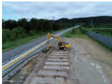
地盤に合わせたセメント改良
