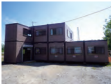
現場事務所の建設
