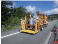
区画線除去と引き直し
