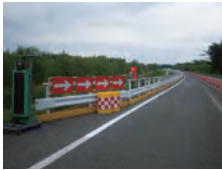
仮設バリケード設置 完了
