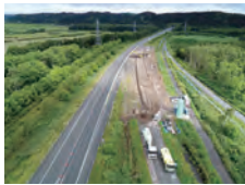
セメント工事現場/ドローン
