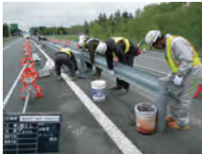
中央分離帯除去、支柱も抜く
