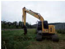
幌富バイパス ランプR側着手
