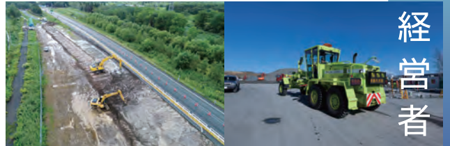
錦産業の特徴は、高い技術力と圧倒的に道路工事に強いこと。また、最新型のICT機械など建設機械を自社で所有していること。
