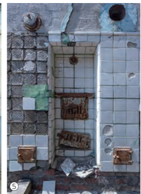
①副会長の熊田さん（左から2人目）からレクチャーを受ける取材陣。②A棟の碇石（がいし）。③C棟には安政3（1856）年に作られた「カッセル」という名のストーブを再現し設置してある。④B棟の浴室。材料はセメントに種石と顔料を混ぜて固めた人研（じんとき）と呼ばれる人造石。当時としてはかなり高価なもの。⑤B棟の暖房は朝鮮半島でみられるオンドルのものらしい。⑥B棟。屋根が崩落した後に組まれた鉄骨。れんがの壁を支えている。⑦B棟内部。会議室だろうか。⑧B棟にある寝室。ベッドは当時のものではなく、NHKテレビドラマ「望郷」で使われたセット。
