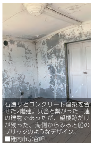
石造りとコンクリート建築を合わせた2階建。兵舎と繋がった一連の建物であったが、望楼跡だけが残った。海側からみると船のブリッジのようなデザイン。■稚内市宗谷岬
