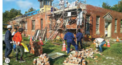
⑨A棟とB棟。⑩熊田さんから「50mと35mの鉄塔（アンテナ）があった」と説明を受けるスタッフ陣。⑪A・B/A棟。別角度から。⑫C棟の修復現場。⑬C棟の修復を終え、みんなで記念撮影。⑭「平和の灯」後の講演会。C棟にて。⑮回雪散策会。⑯望楼まわりを含む屋根の修復。⑰桜の植樹会⑱A・B/毎年12月8日に行われている「平和の灯」。⑲れんがを積もう会。崩れ落ちた約600個が元の鞘に収まるように積まれた。⑳植樹後に花を咲かせたエゾヤマザクラ。
