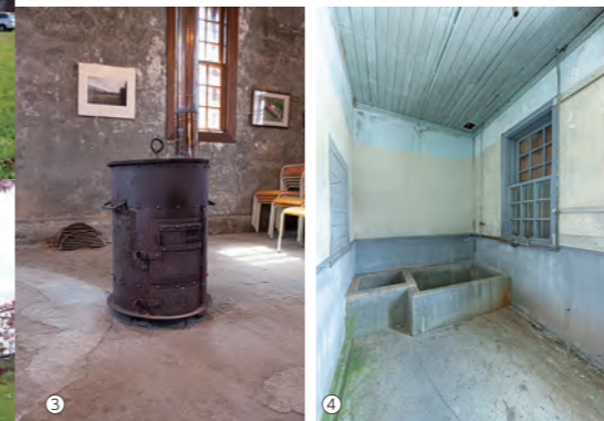
①副会長の熊田さん（左から2人目）からレクチャーを受ける取材陣。②A棟の碇石（がいし）。③C棟には安政3（1856）年に作られた「カッセル」という名のストーブを再現し設置してある。④B棟の浴室。材料はセメントに種石と顔料を混ぜて固めた人研（じんとき）と呼ばれる人造石。当時としてはかなり高価なもの。⑤B棟の暖房は朝鮮半島でみられるオンドルのものらしい。⑥B棟。屋根が崩落した後に組まれた鉄骨。れんがの壁を支えている。⑦B棟内部。会議室だろうか。⑧B棟にある寝室。ベッドは当時のものではなく、NHKテレビドラマ「望郷」で使われたセット。
