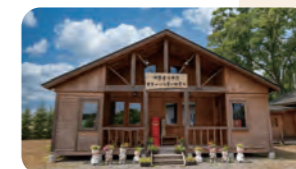
看板と宿泊棟
