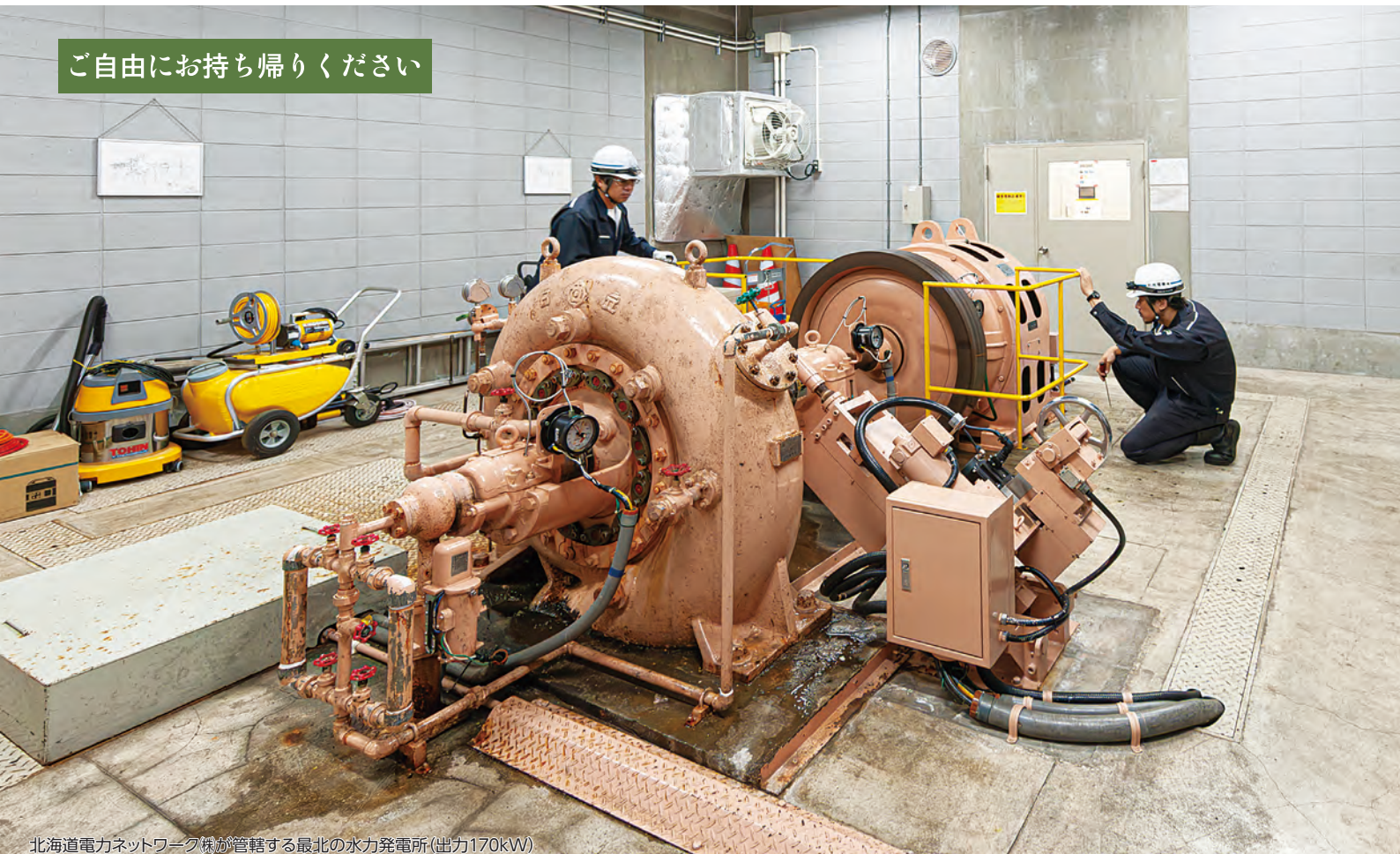
北海道電力ネットワーク様が管轄する最北の水力発電所(出力170kW) 姫沼の余水ほか4河川を用いて発電
