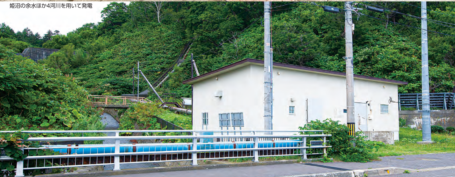
北海道電力ネットワーク様が管轄する最北の水力発電所(出力170kW) 姫沼の余水ほか4河川を用いて発電
