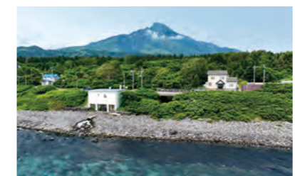
利尻島で最も古い、鬼脇にある小さな清川発電所。
