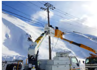
大備下水ポンプ電線改修工事
