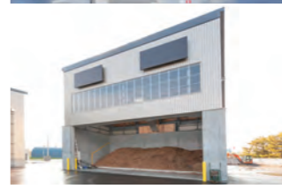
太陽熱を利用して木質チップを乾燥させるエコな乾燥設備。
