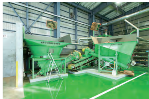
紙おむつ原料定量供給機と木質チップ供給機
