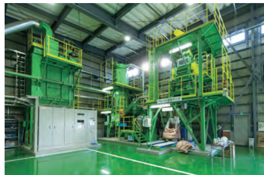
造粒機できあがった混合ペレットを袋詰め
