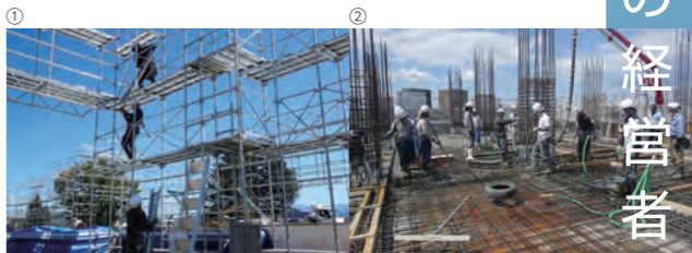
①足場の組立は、鷹の主要な作業の一つ。国内では足場の組立・解体作業には特別教育を受けた者しか従事することができない。②建物の基礎部分や柱・壁などをつくるために、生のコンクリートを枠組みに流し込み、固めるコンクリート工事も美馬組の仕事。
