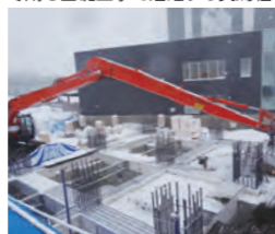
冬期も基礎工事で活躍する美馬組
