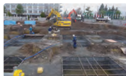
大小を問わず、どんな建物を建てる時でも、一番最初に行われるのが基礎工事となる土工事。掘削（穴掘）も鷹の重要な仕事。
