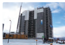
建設現場で塀のように見える仮囲いの設置にも法令や規定に基づいた基準があり、安全のため遵守しなければならない。
