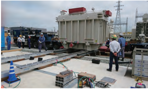
大型変圧器の据付作業
