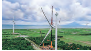
建設中の風力発電用風車
