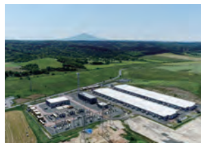
蓄電池設備(北豊富変電所)
