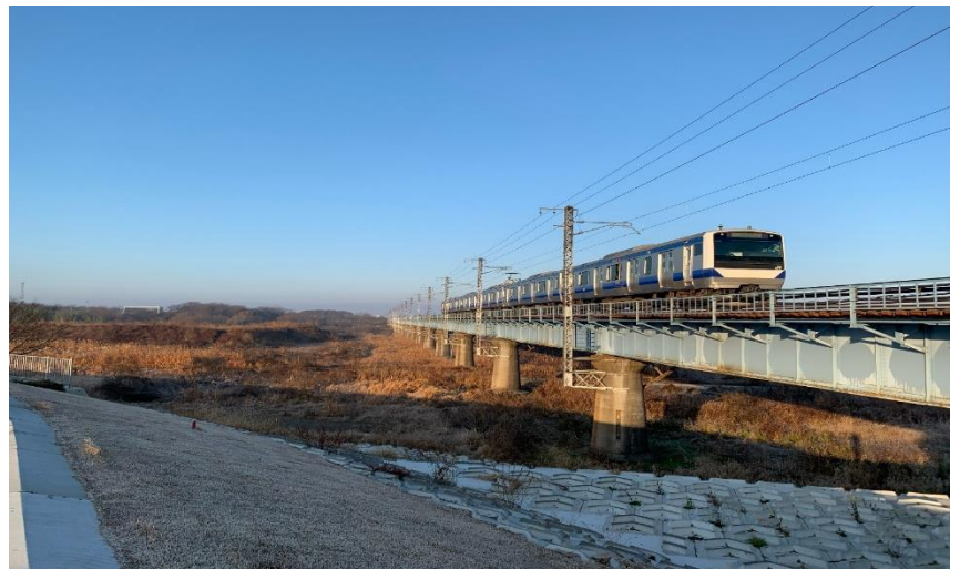
⑩JR 水戸線川島鉄橋と列車（鬼怒川堤防より：筑西市）
